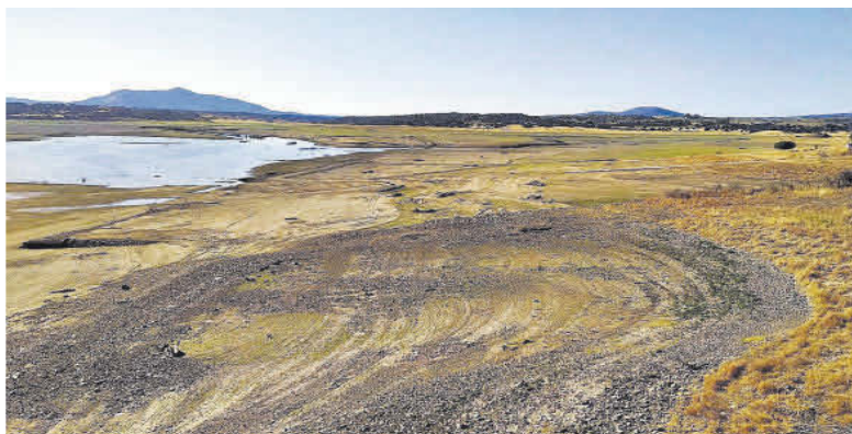
Estado de la presa de Alcollarín tras el vaciado practicado por la CHG.
