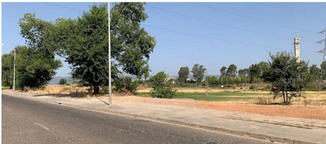
Emacsa concluye la segunda fase de renovación de la red de abastecimiento en el polígono industrial Las QuemadasEmacsa
